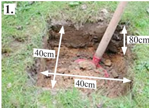
Eine Grube für jeden Pfosten ausheben.
