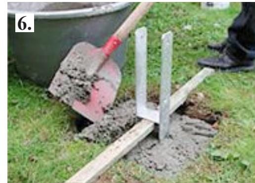
Füllen Sie Beton in das ausgegrabene Loch. Der H-Pfostenanker bleibt weiterhin mit der Leiste fixiert. Danach den Beton glattstreichen.
